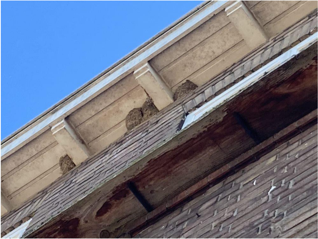
Nesten onder een overstek bij het Stationsplein in Zutphen. Met een mestplank eronder om de uitstekende delen aan de gevel schoon te houden van naar beneden vallende vogelpoep.
