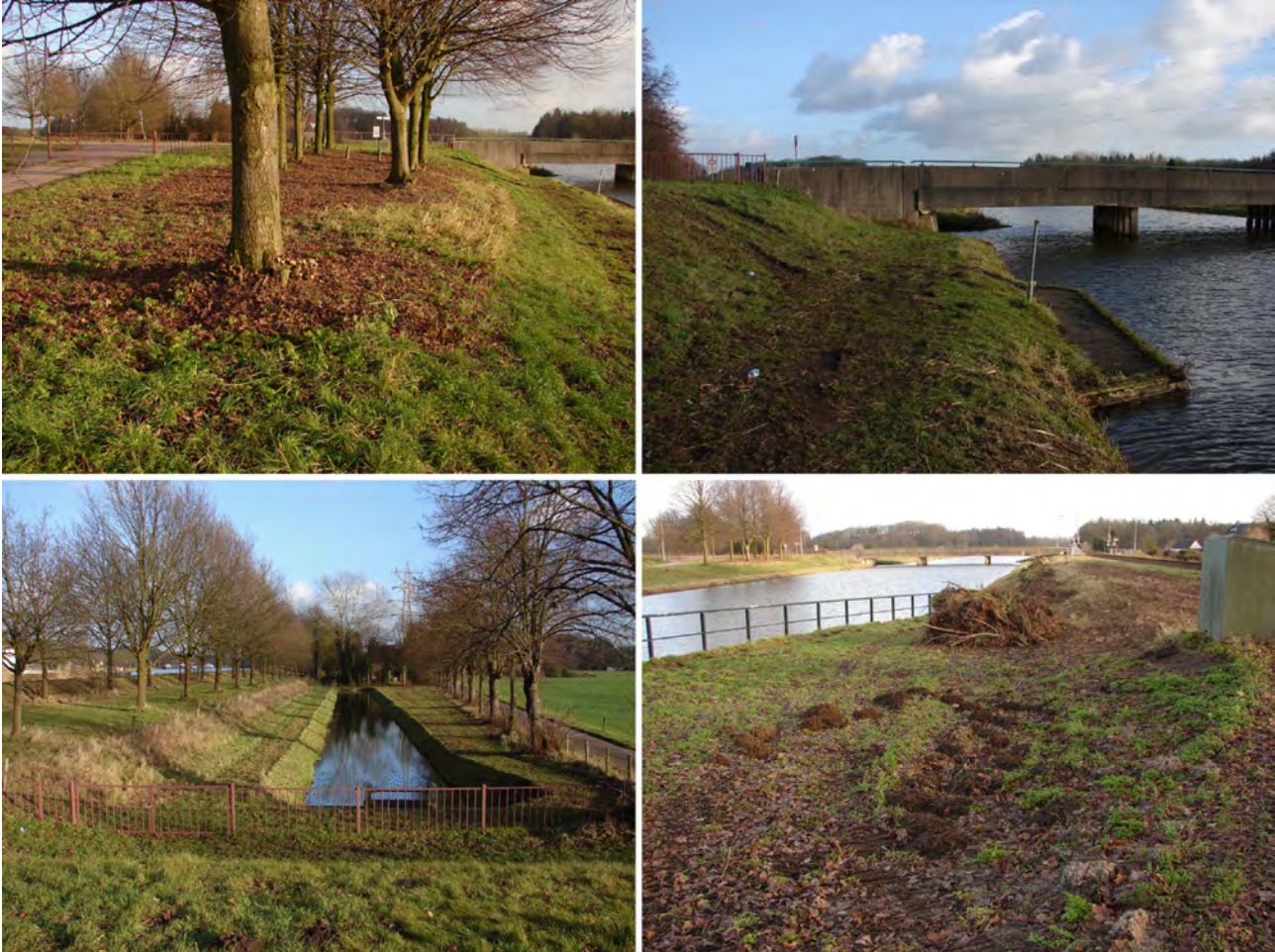
December 2008. Onderhoudssituatie omgeving sluizen bij Eefde
