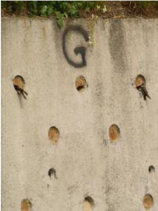
De oeverwaluwwand in de buurt van de Reest
