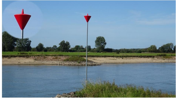
Een nieuw, vogelwerend baken langs de IJssel bij Zutphen.
